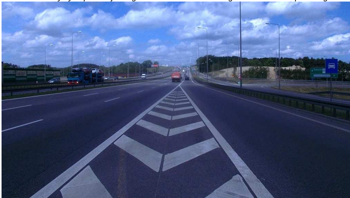
Charakterystyka przekroju drogi i otoczenia analizowanego odcinka niebezpiecznego
