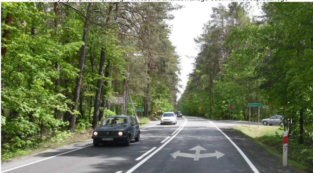
Charakterystyka przekroju drogi i otoczenia analizowanego odcinka niebezpiecznego
