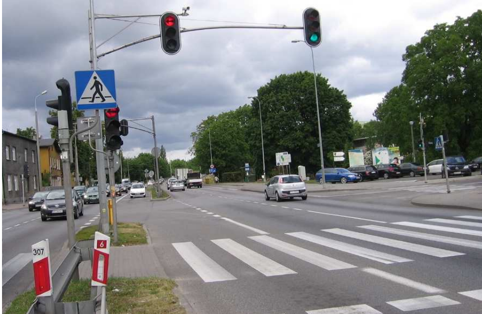
Charakterystyka przekroju drogi i otoczenia analizowanego odcinka niebezpiecznego
