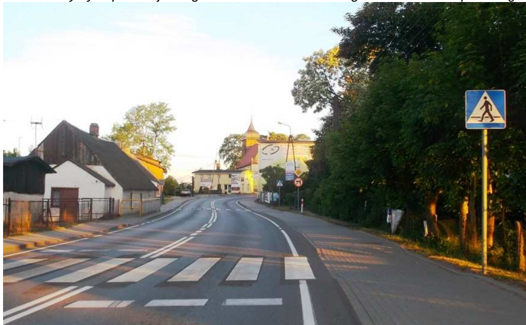
Charakterystyka przekroju drogi i otoczenia analizowanego odcinka niebezpiecznego
