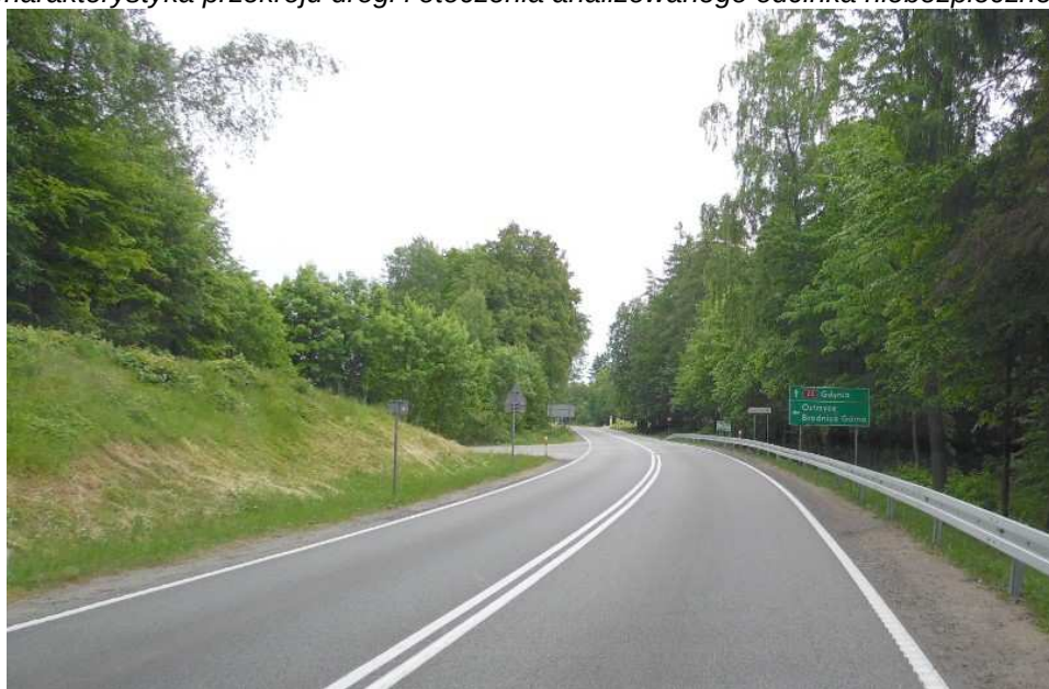
Charakterystyka przekroju drogi i otoczenia analizowanego odcinka niebezpiecznego
