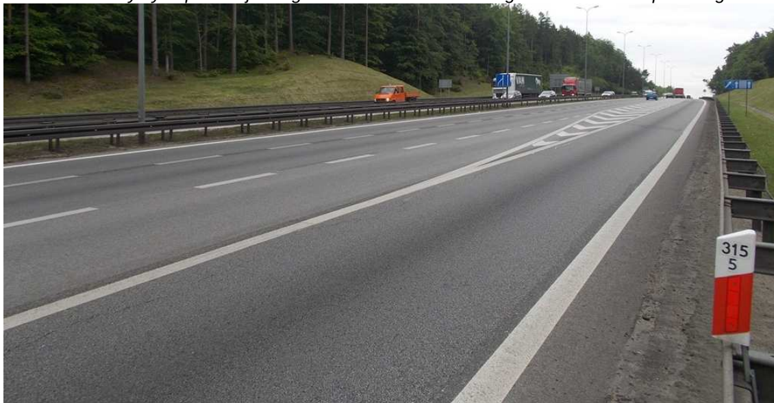
Charakterystyka przekroju drogi i otoczenia analizowanego odcinka niebezpiecznego
