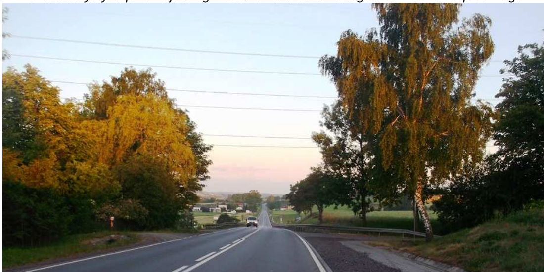
Charakterystyka przekroju drogi i otoczenia analizowanego odcinka niebezpiecznego
